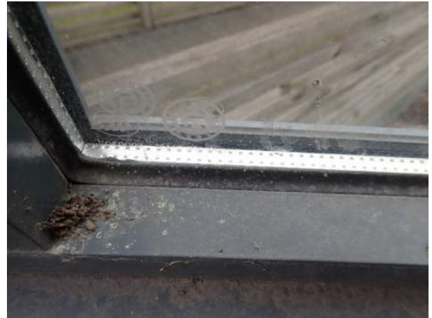
Figur 11. Fönster som förekommer är moderna isolerglas, dock stämplade med Kinesiska stämplar.
