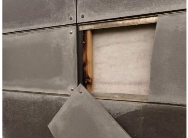
Figur 3. Mineraliska skivor i fasad, regelverk av trä med gummidistans och ståldistans. (Prov 1).
