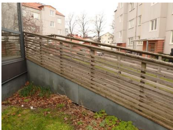
Figur 26. Tryckimpregnerat virke i trall.
