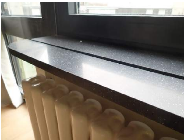
Figur 12. Fönsterbänk i sten innehåller inte asbest enligt analys. (Prov 3).
