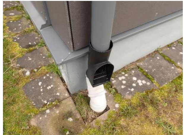
Figur 9. Takavvattning sker i i stuprännor i plåt.
