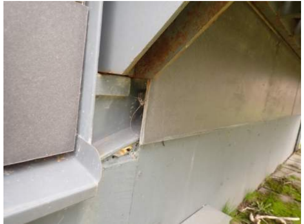
Figur 5. Balkongen är monterad på stålbalk in i sockeln. Stålet bedöms ej vara målat med blyfärg.
