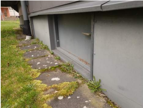
Figur 6. Hela bostadsmodulen vilar på en grundläggning av betong och isolerad sockel. Inspektionsluckan var stängd vid tillfället för inventering. Ljusgrå skiva är analyserad för asbest men innehåller inte det (Prov 2).
