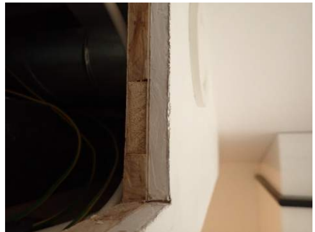
Figur 17. Innerväggar består av trä och gips.
