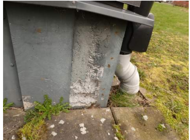
Figur 7. Sockeln är i delar isolerad, isoleringen består av frigolit. Hela sockeln är målad.
