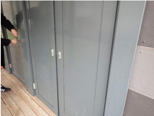
Figur 10. Dörrar som förekommer är i plast/plåt.
