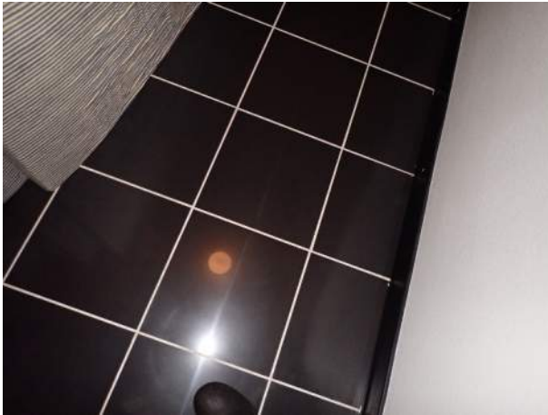
Figur 14. Golvtytskikt i sten innehåller inte asbest enligt analys. (Prov 4).
