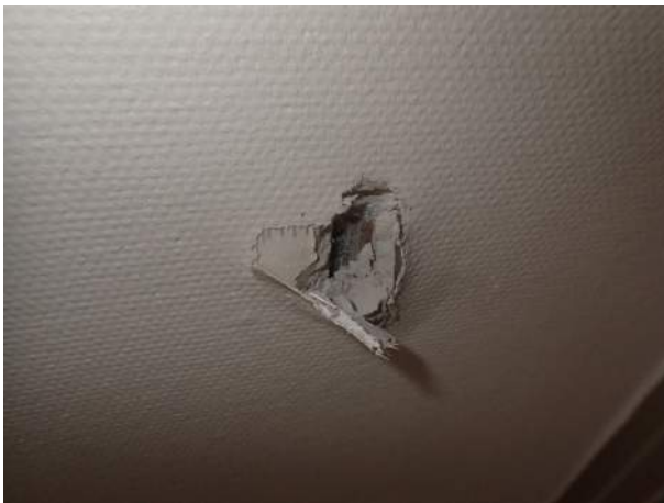
Figur 16. Innerväggar av gips, innehåller inte asbest enligt analys. (Prov 6).
