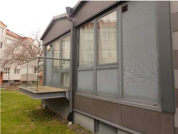
Figur 4. Bostadsmodul med tillhörande balkong, utförd i plast, plåt och vilar på en grundläggning av betongplintar och isolerad sockel.
